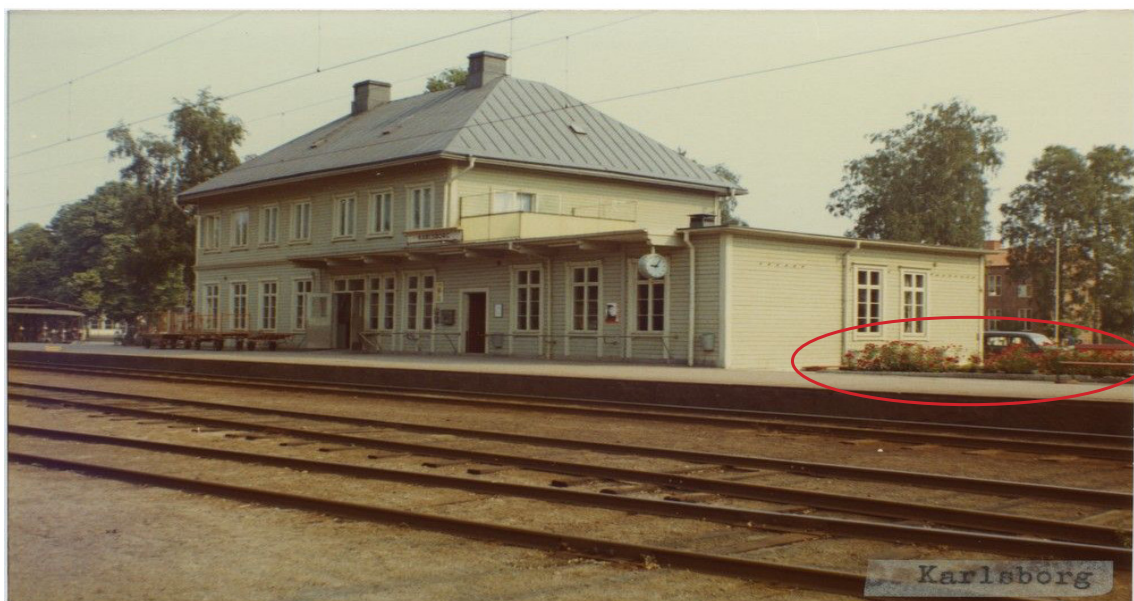
Figur 11. Karlsborg stationshus från spårvidan. taget från sydväst mot nordost. Daterad till 1968 – 1969 (Samlingsportalen, 2018).
