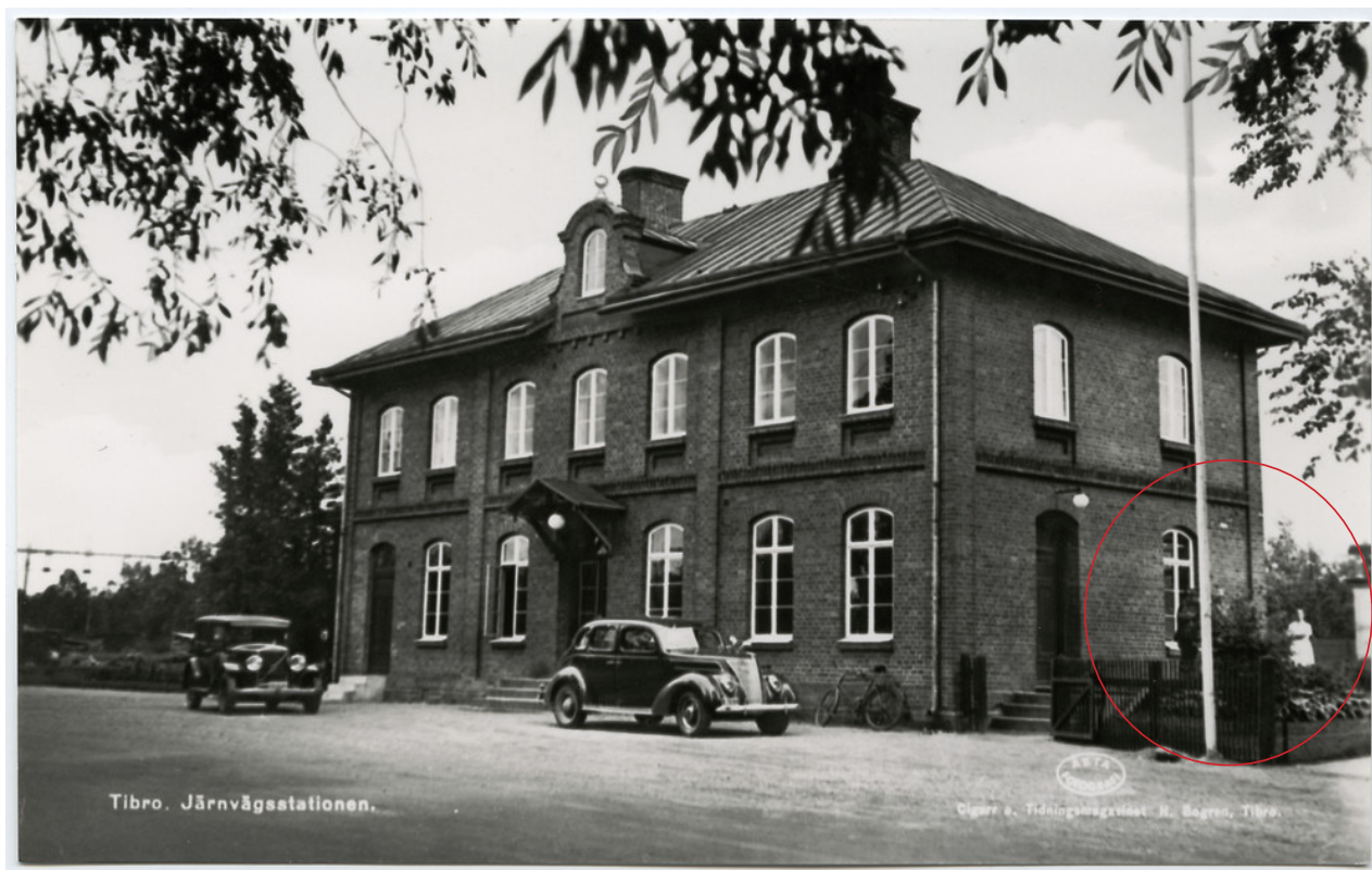
Figur 26. Tibro stationshus, daterat till år 1940. Taget från entrésidan från nordväst mot sydost (Samlingsportalen, 2018).
