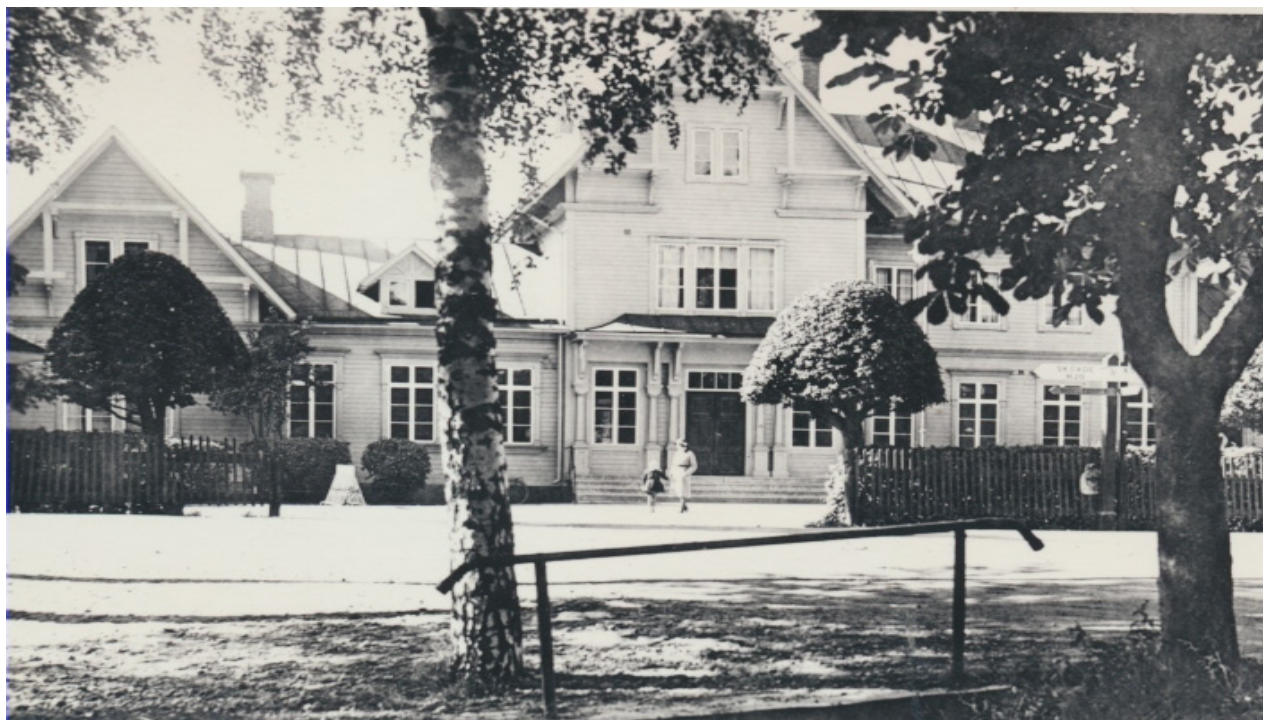
Figur 7. Karlsborgs stationshus, u.å. Fotot är troligen taget runt år 1920. Taget från vägsidan från öst mot väster (Digitalt museum, 2018).
