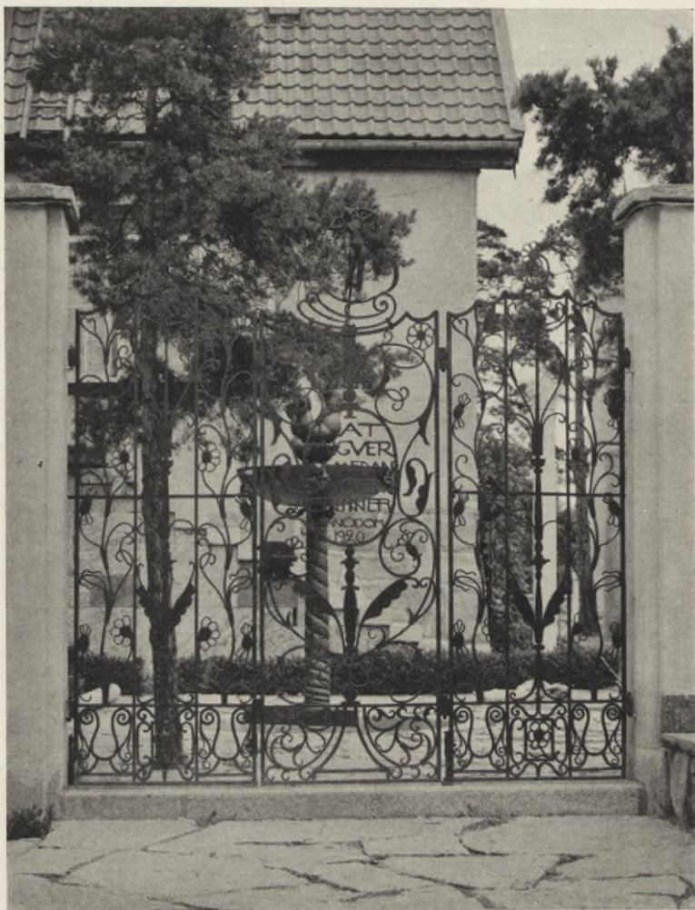
325. SMIDESJÄRNSPORT TILL CARL MILLES' HEM PÅ HERSERUD, LIDINGÖN. Tecknad av Carl Milles, utförd av Peter Andersson i Myra 1920.
