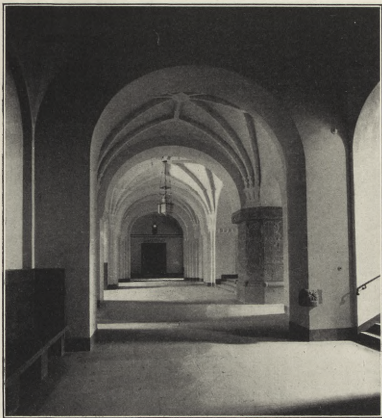
283. VÄLVD GÅNG I STOCKHOLMS RÅDHUS. Byggnaden uppförd av Carl Westman 1915.
