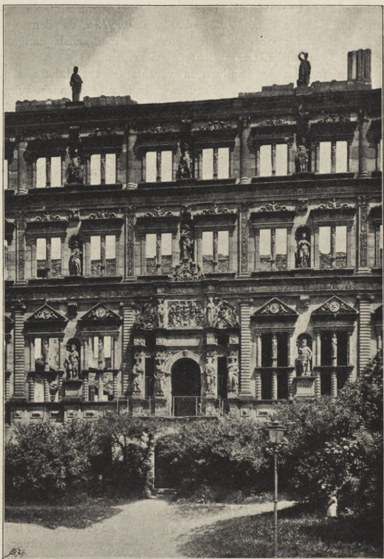
344. OTTO-HEINRICHS-BAU, ÄLDSTA DELEN AF SLOTTET I HEIDELBERG. Byggt på 1550-talet.
