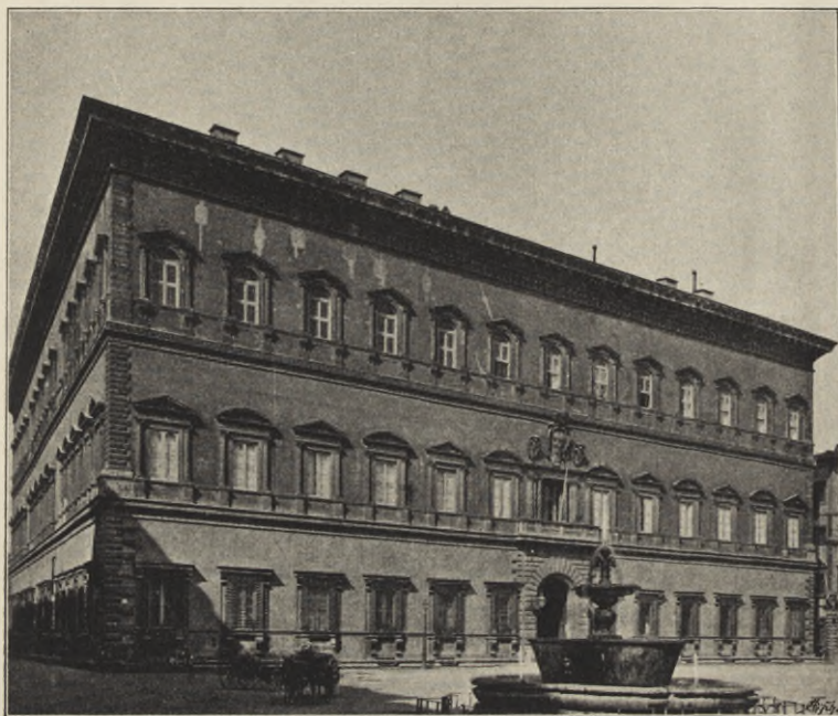
223. PALAZZO FARNESE I ROM. Byggt af Antonio da San Gallo d. y.
