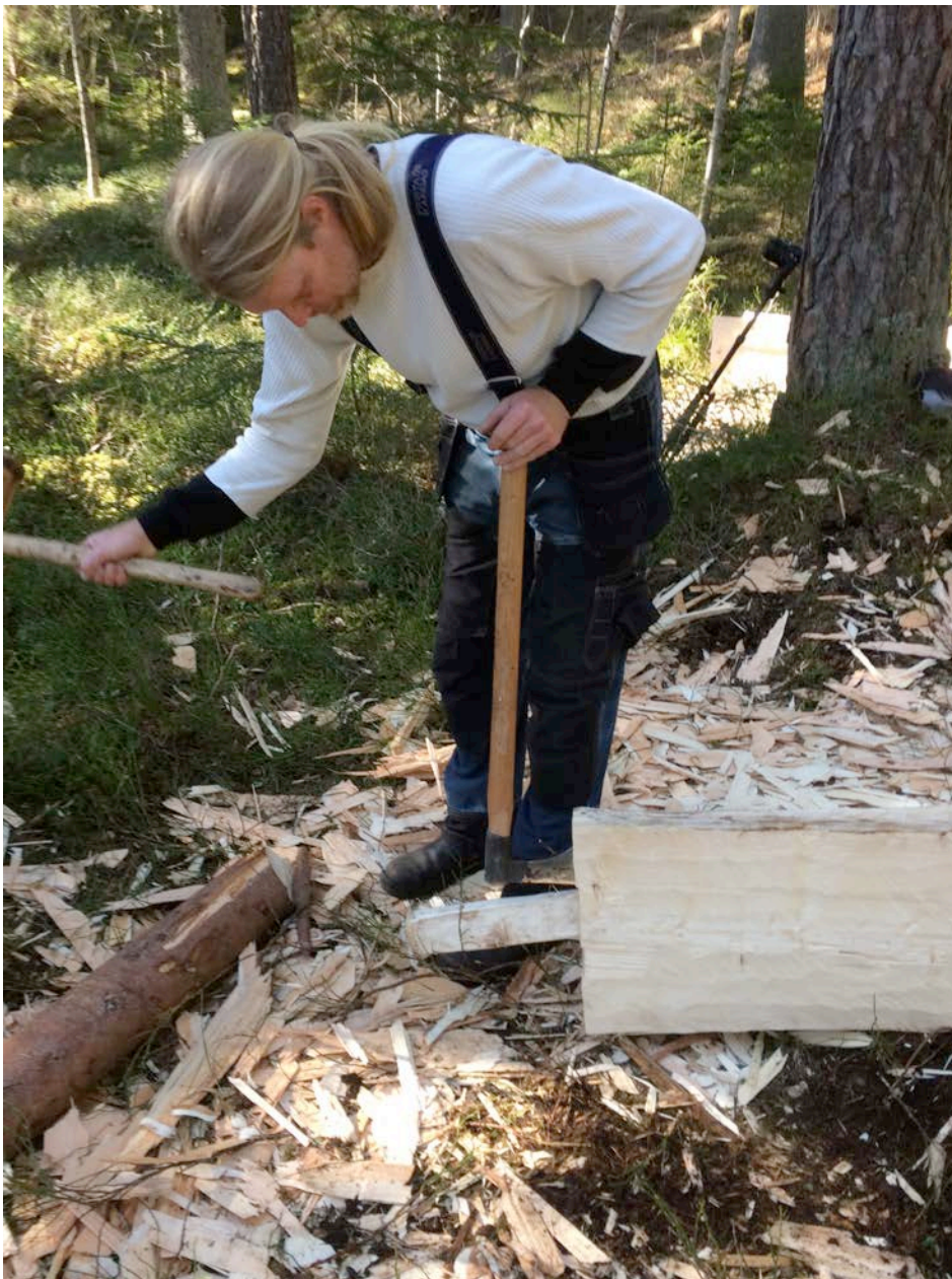
Fig. 10 "Väckning", notera kilen under yxan.
