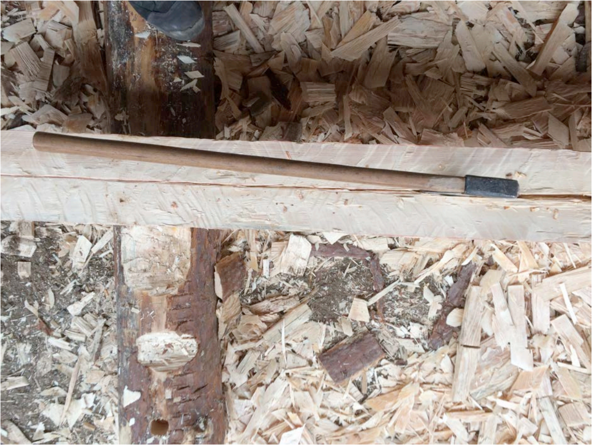
Fig. 22 Spårning, Detalj: Observera snedställningen av yxan.
