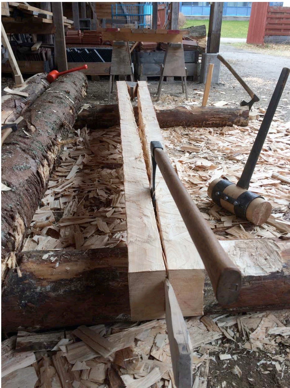
Fig. 23 Spårning, Detalj: Spår öppnat, kilar inslagna en bit.
