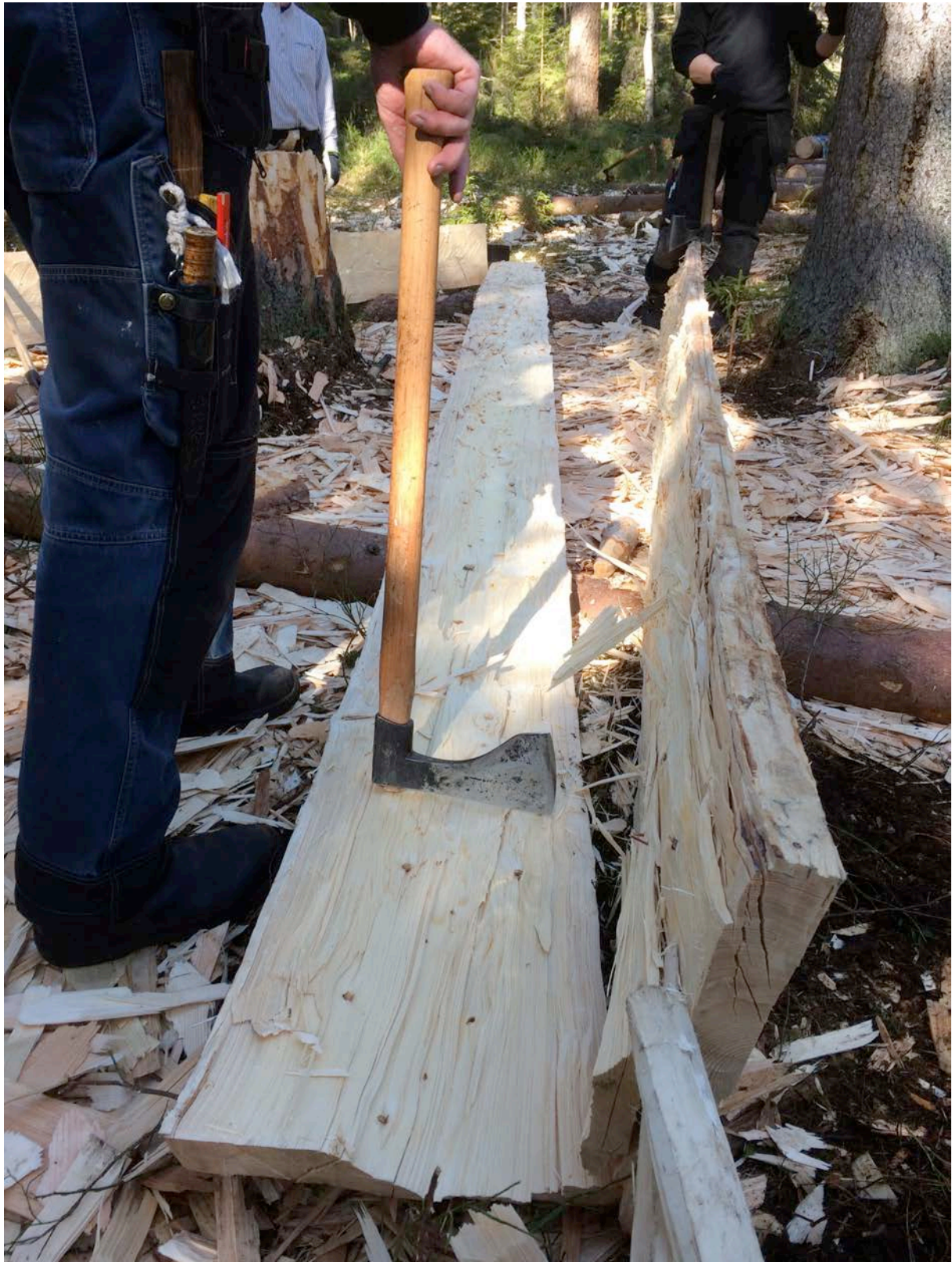
Fig. 13 Klyvningen klar, resultatet kallas brädämnen.
