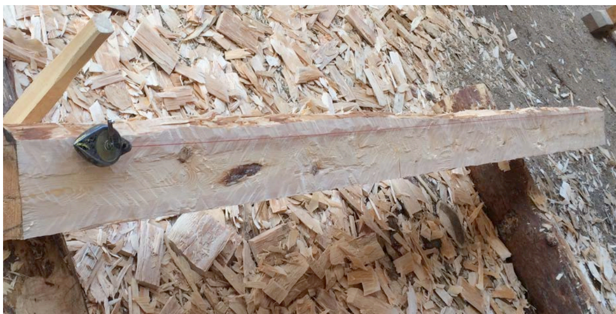
Fig. 17 Snörslagning
