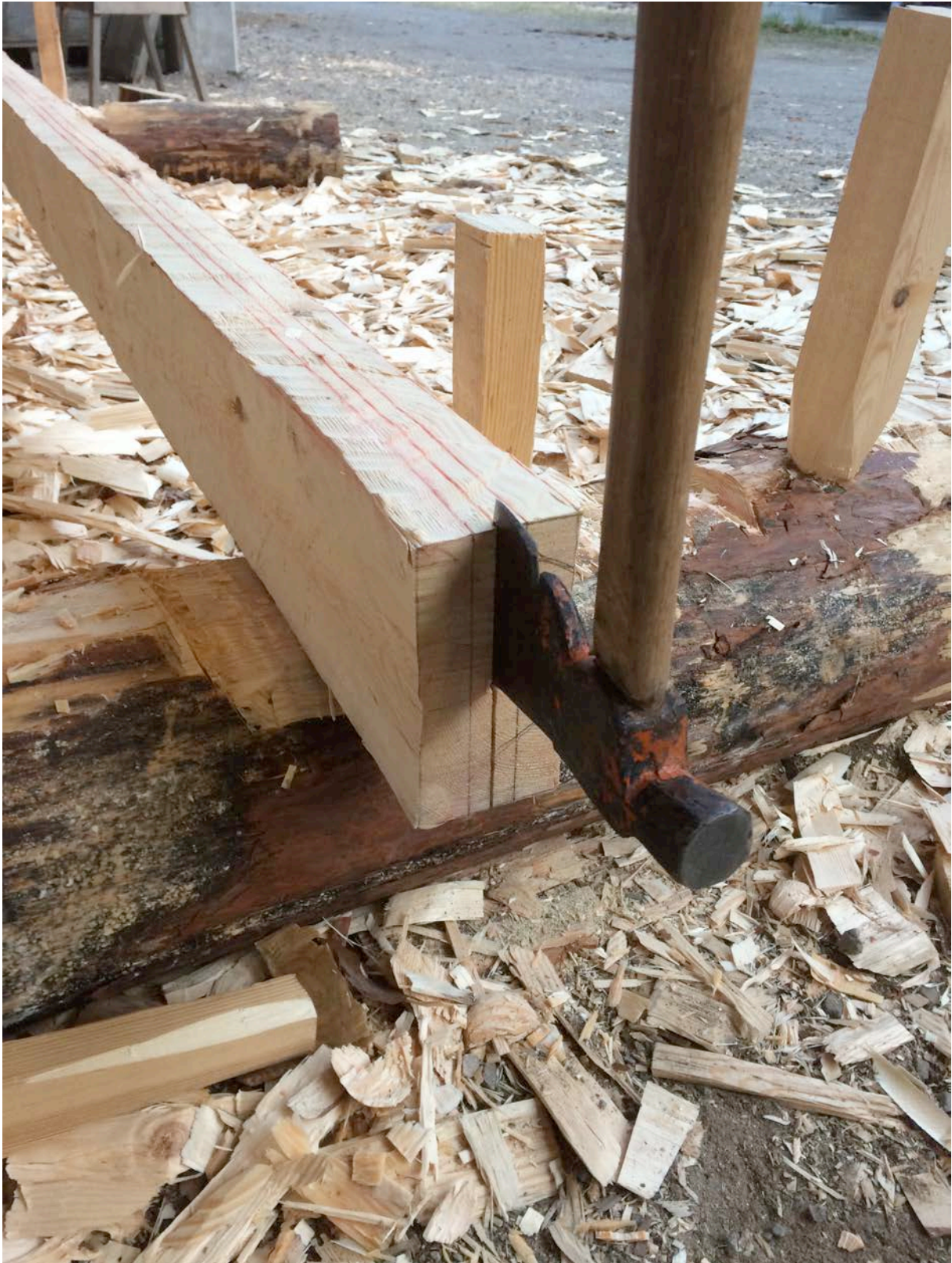
Fig. 20 "Väckning" med tunn snickaryxa. Notera de snörslagna linjerna för klyvspåret.
