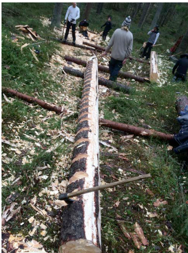
Fig. 7 Grovberedning av stock, här ses skyrhuggen innan klamphuggning.
