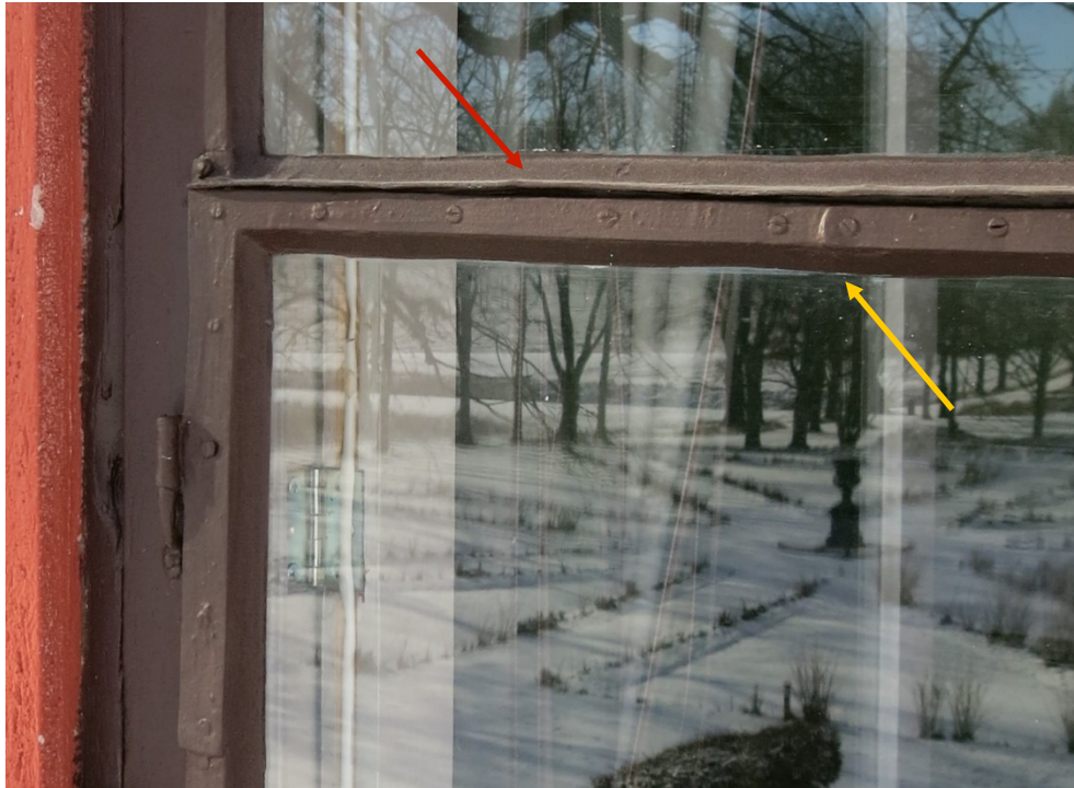
Figur 29. Det sitter en droppnäsa av plåt på bågen ovanför lättrutan (röd pil). De långa skänklarna på hörngångjärnen och hörnjärnen bildar en 4 mm fals. Hörnjärnen ligger lite omlott och täcker hela utsidan av lättrutebågen (gul pil).
