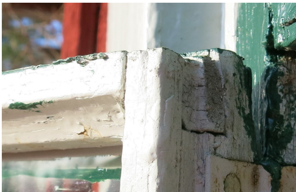
Figur 43. Lättrutans tapp, slits och fals.
