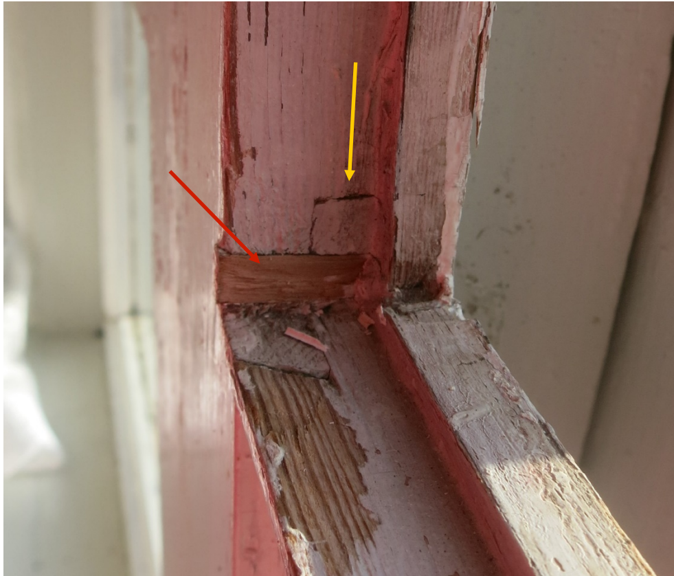
Figur 35. Bågens spröjs är smalare än tappen (röd pil). Spröjspinnarna är kluvna (gul pil).
