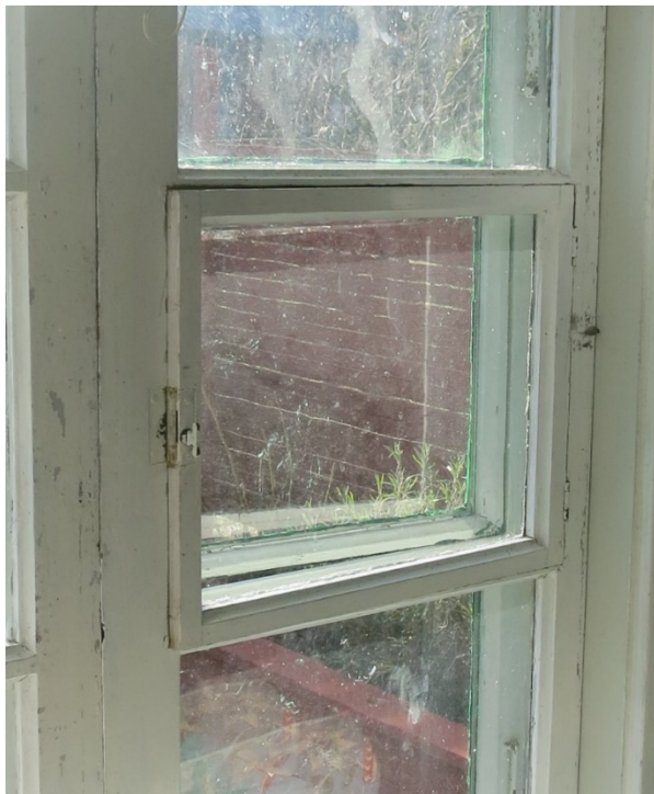
Figur 1. Fönsterbåge från Årnäs 2:1. Innerbåge med lättruta som öppnas inåt.
