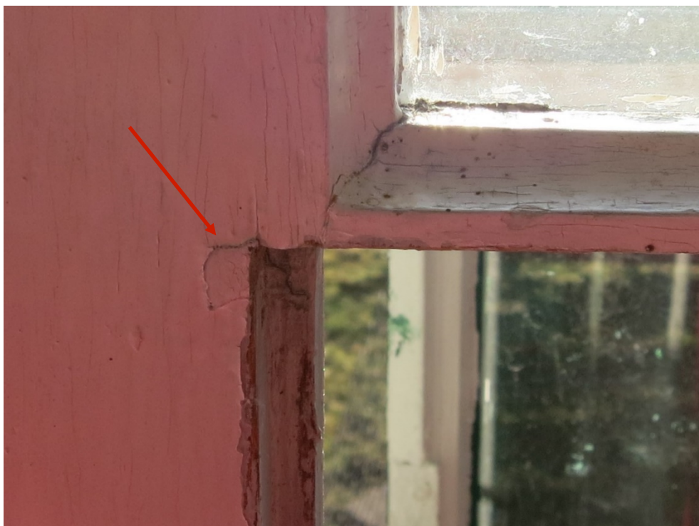
Figur 36. Kluven spröjspinne.
