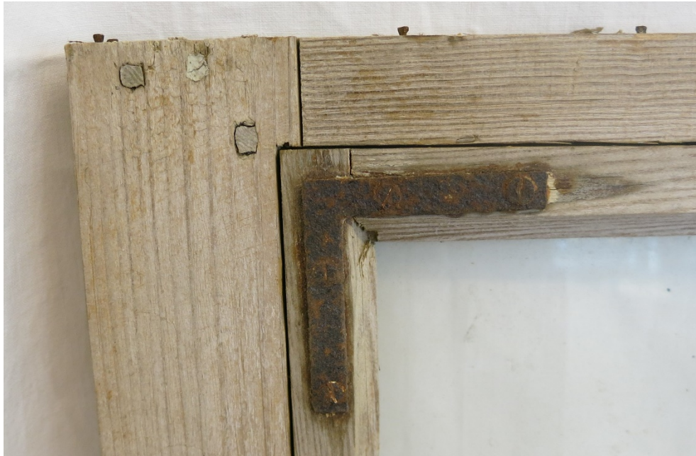
Figur 7. Insida. Lättrutans hörnbeslag.
