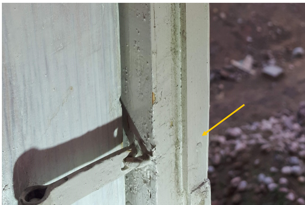
Figur 19. Påspikad list som bildar en fals i bågen.
