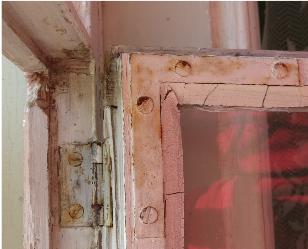
Figur 37. Lättrutan är sammanfogad med tapp och slits. Det sitter hörnjärn på utsidan.
