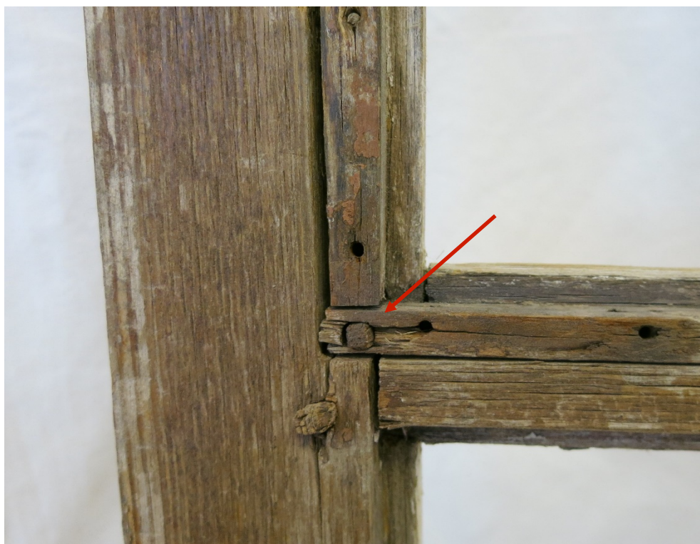
Figur 11. Lättrutan är sammanfogad med tapp och slits med en 4 mm pinne i varje hörn
