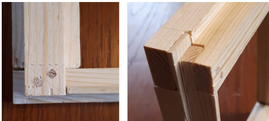
Figur 4. Till vänster. Detalj från utsidan på lättrutan. Den lilla ytan där pinnarna sitter är endast 12 x 16 mm. Till höger. Sammanfogning med tapp och slits och två pinnar.
