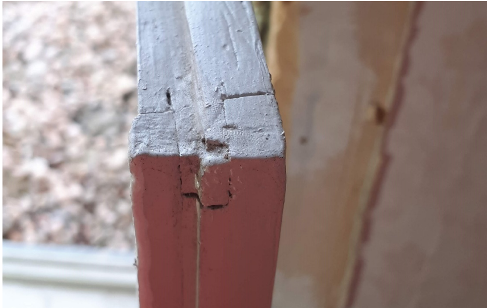
Figur 17. Lättrutans tapp och slits.
