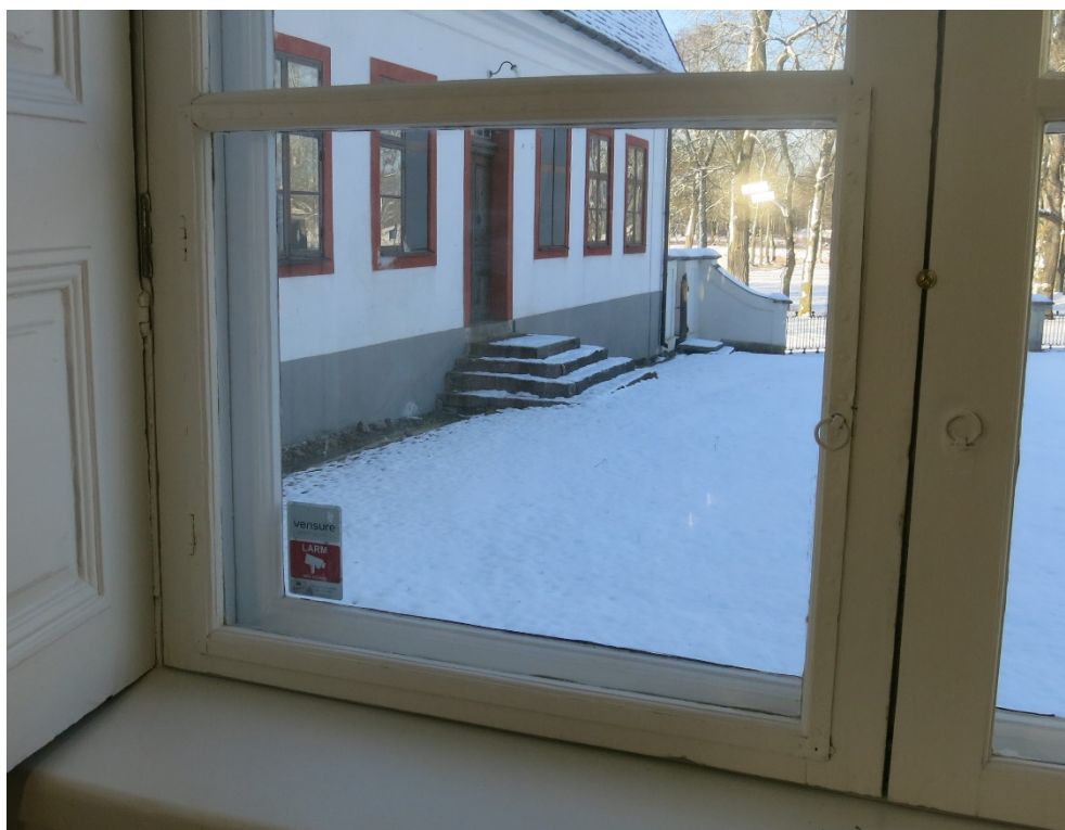
Figur 25. Hela lätttrutan med sin metallfals på insidan.
