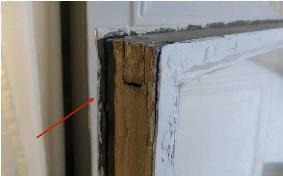
Figur 24. Lättrutan och bågen har ingen fals. Metallbeslag bildar en 5 mm fals runt om (röd pil).
