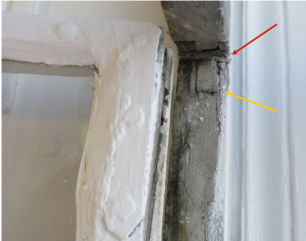
Figur 23. Lättrutans hörnjärn. Spröjset är smalare än tappen (gul pil). Bågens pinne är kluven (röd pil).
