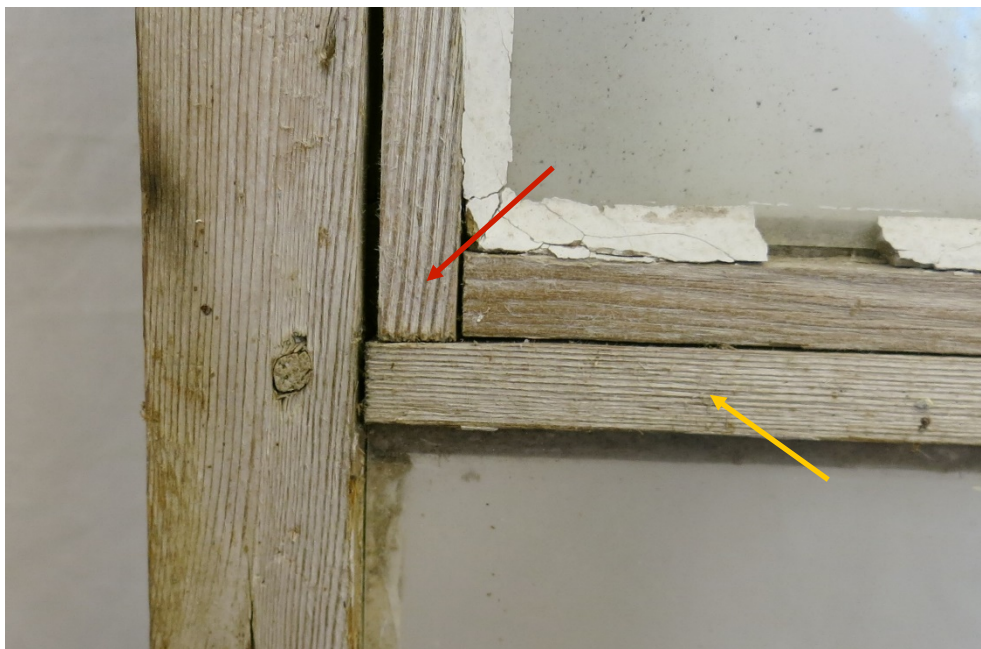
Figur 8. Utsida. Lättruta (röd pil), spröjs (gul pil).
