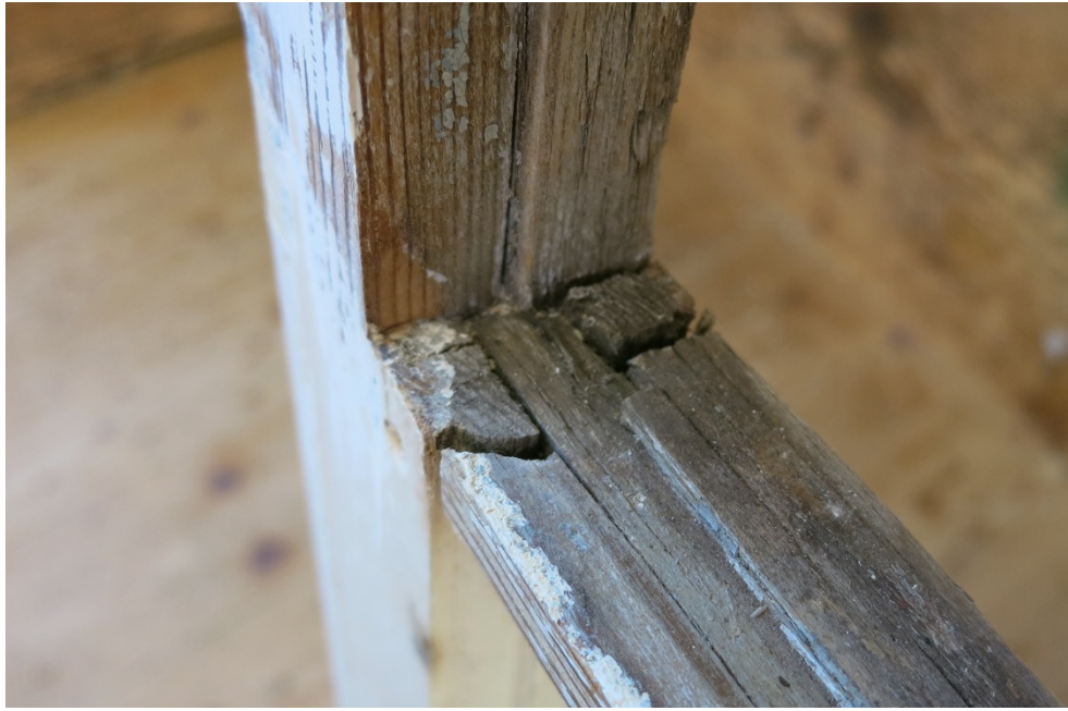
Figur 13. Bågens spröjtappar har samma form som spröjsen
