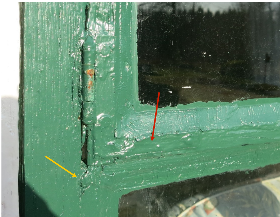
Figur 42. Spröjssets pinne är placerad något under lättrutan (gul pil). Lättrutans hörnjärn skymtar bakom färglagren (röd pil).
