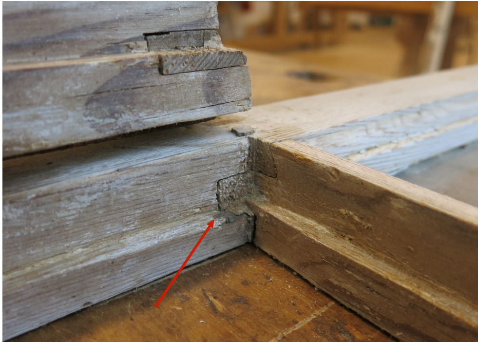
Figur 5. Spröjssets bredare tapp (röd pil).
