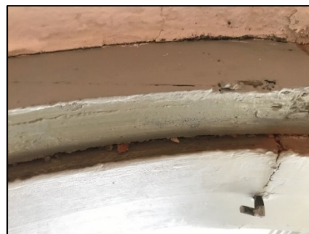
Bild 52 – Grus som tagit sig mellan ytterfalsdelen och stomdelen.
