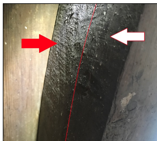
Bild 55 – Vindskarmens utsida. Det röda strecket visar lötarnas skarv. Röda pilen visar på sågspår från handsåg, vita pilen visar hyvelspår som uppkommit av justering av ytan, som var högre på den inre lötningslagret jämfört med det yttre.
