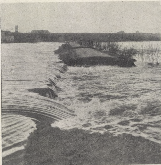
FRÅN ÖFVERSVÄMNINGARNA I FRANKRIKE: De sprängda fördämningarna vid Nantes, uppförda till skydd mot Loires öfversvämningar. Genom flodens genombrytande här blef Nantes räddadt från en fruktansvärd katastrof — på den kringliggande landsbygdens bekostnad.
