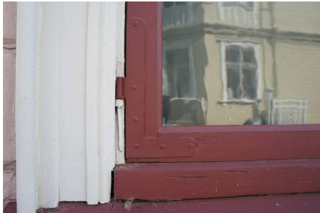
Figur 7. Hörnjärn och gångjärn i ett stycke. Foto: Victoria Korth.
