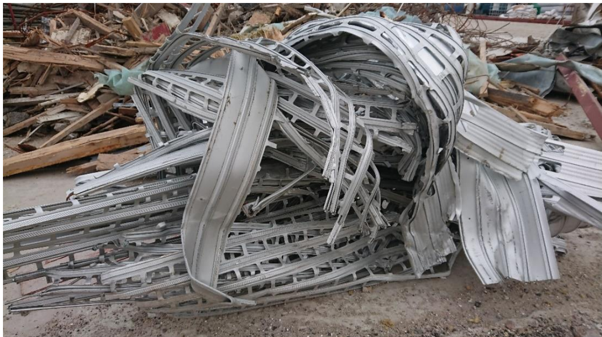
FIGUR 12. TRASIGA ÖPPNINGS- OCH STÄNGNINGS-JALUSIER VID RIVNINGSPLETSEN. FOTO: LINA NYVALLER
