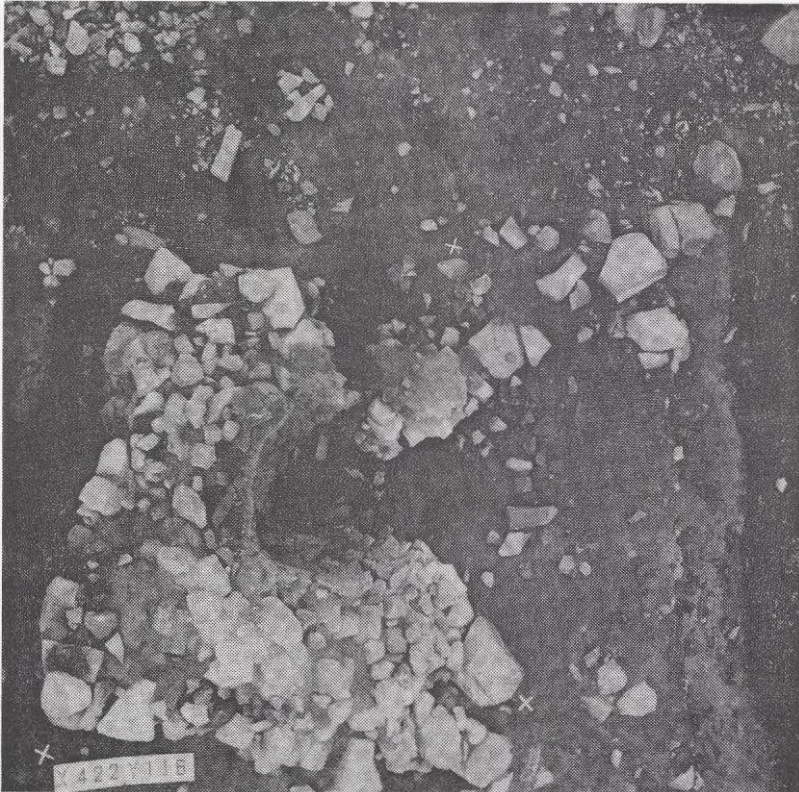
Fig. 3. Masugnsruinen sedd ovanifrån. Utslagsbröstet t.h. på bilden. Formbröstet vänder uppåt. Hyttbäcken i bildens högra kant. Jfr. Fig. 1. Observera dock att utslagsbröstet här är vänt från hyttbäcken.
