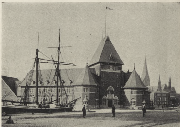
114. TULLHUSET I ÅRHUS. Byggt av Hack Kampmann 1902.
