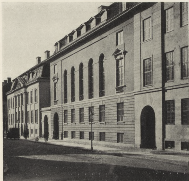
120. DANSK DAMPSKIBSREDERIFORENINGS BYGGNAD I KÖPENHAMN. Uppförd av Emanuel Monberg 1920—23.
