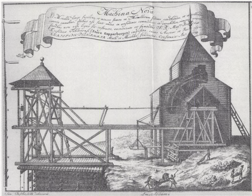
FIGUR I. Polhems blankstötmaskin blev mycket omtalad. Polhem lät själv göra ett kopparstick under sin vistelse i Amsterdam, efter en förlaga av sin medresenär Samuel Buschensfelt. Den kom senare att publiceras i ett antal publikationer, som i Olof Naucalers Delinatio magnæ fodinæ Cuprimontanæ (1702), Swedenborgs redigerade Dædalus Hyperboreus (1716), Franz Ernst Brückmann, Magnalia Dei (1727), och Swedenborgs De cupro (1734).
