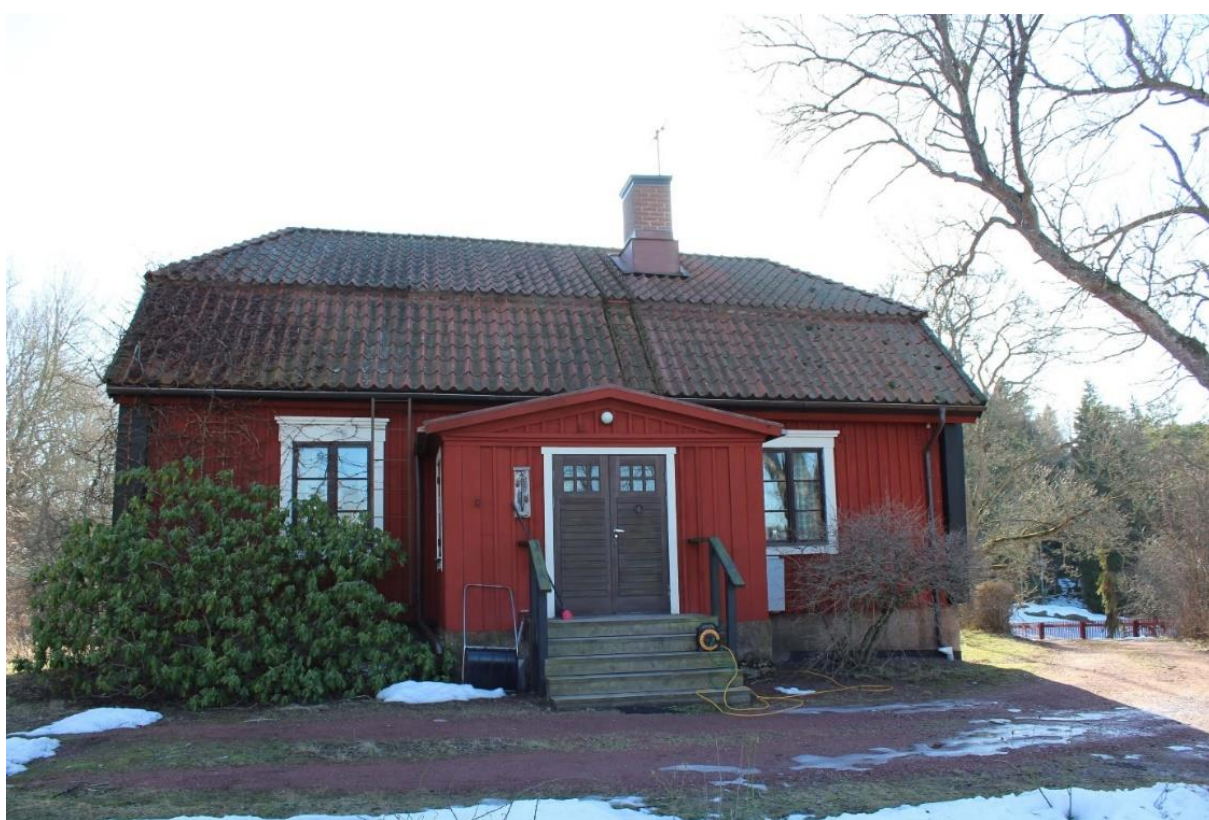
Figur 28 Mangårdsbyggnaden vid Bergs gård.
