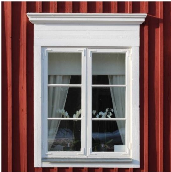
Figur 19 Kollage av detaljer signifikanta för Rudskogs byggnader. Låga fönster under långsidans takfot, lunettfönster i gavelspetsen, brett överstycke i fönstrets foder, dubbla lunettfönster i entrédörrens överstycke.
