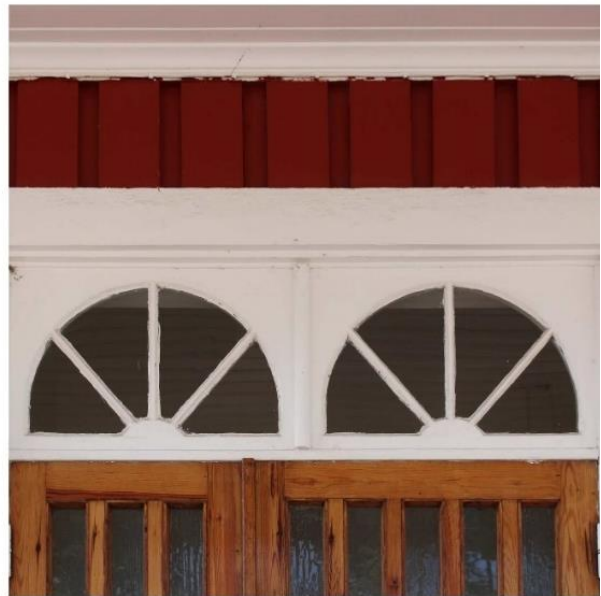
Figur 19 Kollage av detaljer signifikanta för Rudskogs byggnader. Låga fönster under långsidans takfot, lunettfönster i gavelspetsen, brett överstycke i fönstrets foder, dubbla lunettfönster i entrédörrens överstycke.
