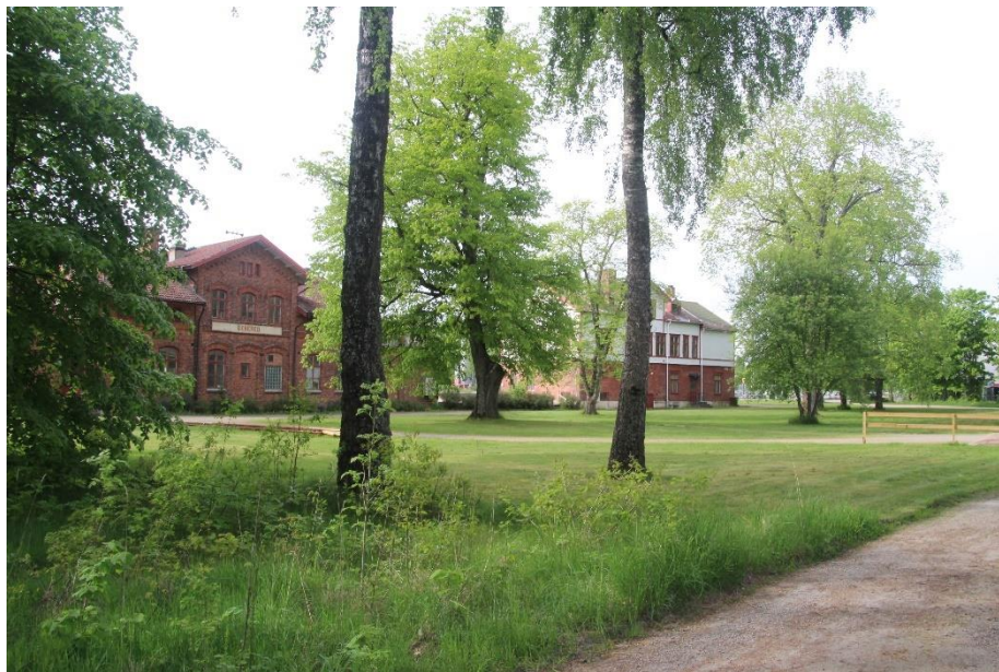
Fig. 46. Stationshuset, järnvägshotellet och järnvägsparken. Kanske ett blivande statligt byggnadsminne?
