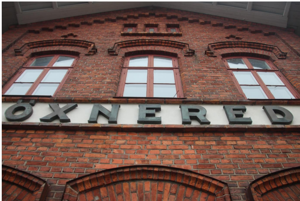
Fig. 15. Stationsnamnets grönoxiderade kopparbokstäver syns tydligt mot den ljusst putsade bakgrunden. I bilden syns också de vackert formade tegelstenarna ovanför fönstren och de två försänkta fyrpassen. Fotograferat i april 2018.
