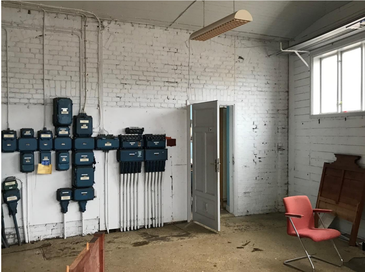
Fig. 23. Godshallen i norra tillbyggnaden från 1906. Precis ovanför de blå elinstallationerna kan man se en rak avlastningsbåge i tegelväggen som innan utbyggnaden var yttervägg. Troligtvis har det suttit en likadan dörr där som den till höger i bilden. Precis under taket finns två segmentsbågvalv som är rester efter fönstren som satt här innan utbyggnaden. Fotograferat i april 2018.
