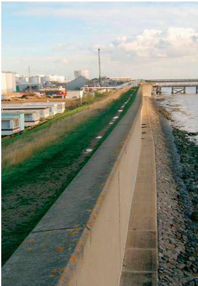
Exempel på kustskydd i Thames kanalen. Här syns det hur kustlinjen är förstärkt med vallar och betongfundament. (källa Environment Agency (2012) ). Example of the the costal protection looks like in the Thames Canal (source: Environment Agency (2012)).
