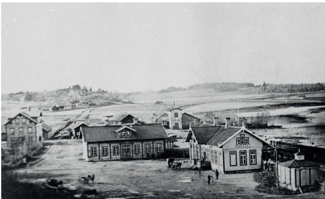
Figur 67. Ett fotografi från Gnesta kan vid en första anblick uppfattas som att det var sparsamt med planteringar kring vissa stationer. Fotografiet är taget runt år 1865. I en atlas från samma tid syns emellertid inte bara planteringarna mellan stationshuset och restaurangen mitt i bilden utan hela järnvägsparken sydväst om stationsplanen. Se Figur 68. Till vänster om restaurangen anas början av parken med ett staket runtom. Fotografiet visar dessutom några planteringar runt avträdet, i det högra hörnet, som inte finns inritade i atlasen. Från: Järnvägs-museet, KBAA01625.
