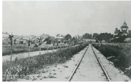
Figur 60. Längs järnvägssträckor utsatta för vind och snö och som brandskydd planterades trädrader. På den här bilden syns nyplanterade lönnar vid spårets ena sida längs en väg i utkanten av Söderhamn, fotograferade före år 1876 enligt texten i det vänstra nedre hörnet på fotografiet. Sträckan hörde vid den här tiden till den enskilda järnvägen Söderhamns järnväg. Bilden är spegelvänd. Från: Järnvägsmuseet KDAA13483.
