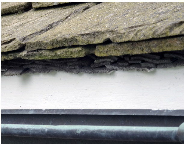
Figur 30. Under de dubbla skifferlagren anas stickespån. Foto: Takskifferprojektet i Karlstads stift.
