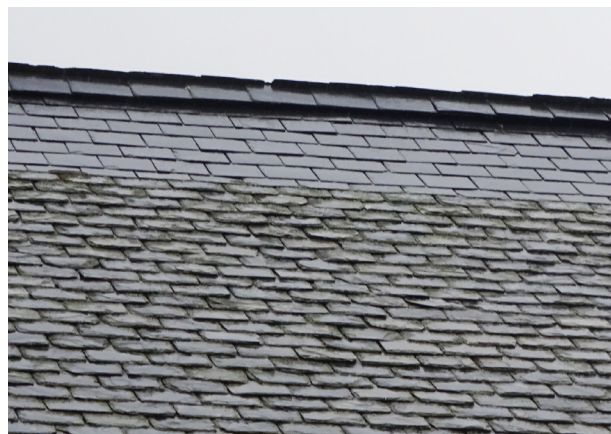
Figur 14. Komplettering med spanskt skiffer längst upp på taket. Foto: Takskifferprojektet i Karlstads stift.
