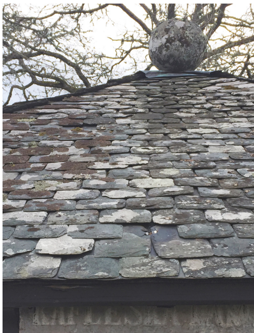
Figur 38. Skifferplattor som saknas på taket till Kafleska familjegraven vid Steneby kyrka i Bengtfors kommun, Norra Dalsland. Foto: Taksifferprojektet i Karlstads stift.
