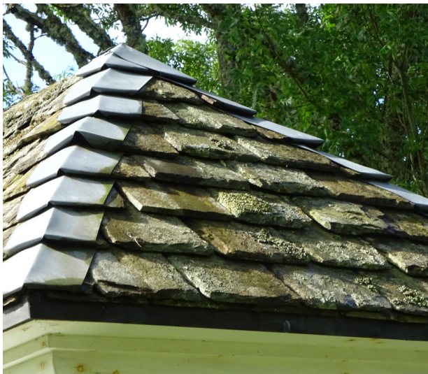
Figur 37. Här har plåt använts för att få en tät snednock. Det är oklart hur det såg ut tidigare men en traditionell lösning utan plåt hade varit att hugga ihop skifferplattorna. Foto: Takskipperprojektet i Karlstads stift.
