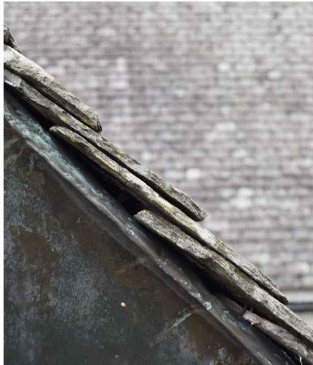
Figur 10. Skiffertak sett från sidan. Täckning med 2-3 lager på Gunnarskogs kyrka i Arvika kommun. Foto: Takskifferprojektet i Karlstads stift.
