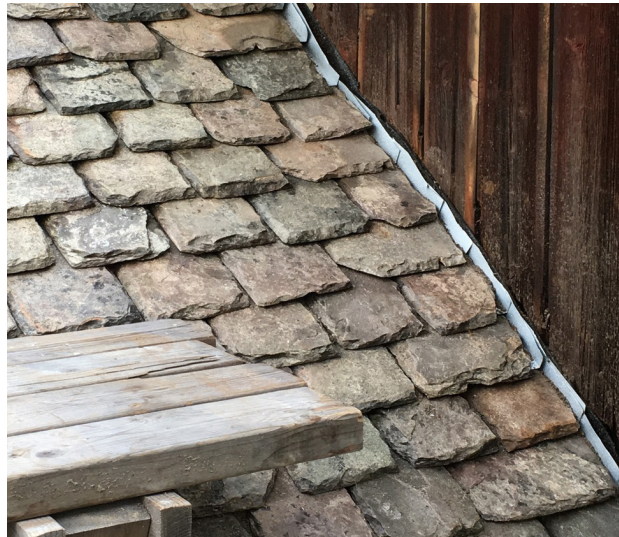
Figur 36. Anslutning mot vägg med inskottsplåtar. Foto: Emil Engkvist.
