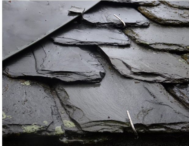
Figur 24. Lagningar med krok. Foto: Takskifferprojektet i Karlstads stift.
