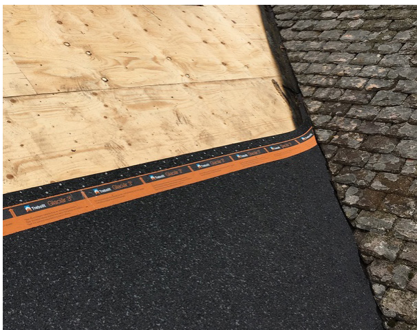
Figur 29. Takpapp rullas ut på det nya underlagstaket av plywood. Foto: Emil Engqvist.
