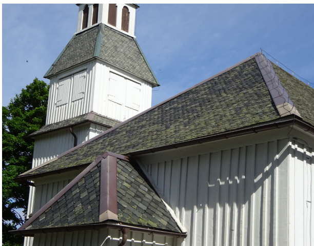
Figur 39. Överdimensionerad plåttäckning på Gesäter kyrka i Dals-Eds kommun, Dalsland. Jämför med fotografiet till höger. Foto: Takskifferprojektet i Karlstads stift.
