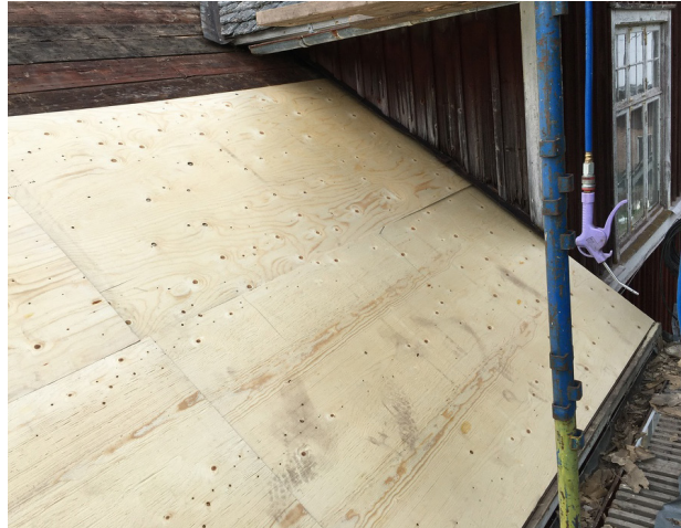
Figur 28. Ett nytt underlagstak av plywood spikas på de gamla underlagsbrädorna för att därefter spika takpapp och lägga tillbaka skiffret. Foto: Emil Engqvist.
