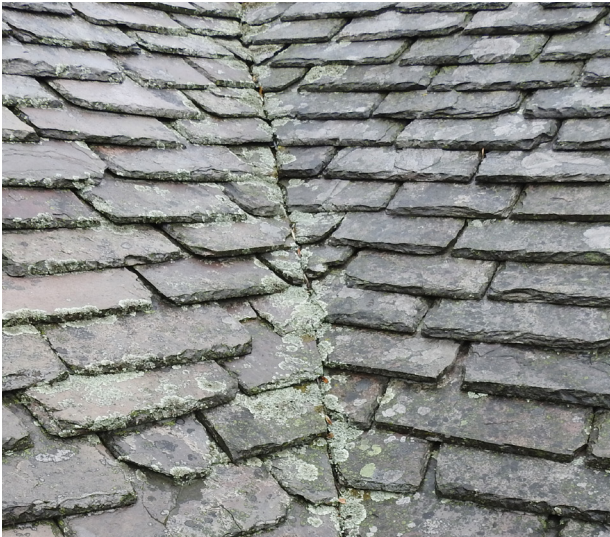
Figur 35. Ihophuggen lutande rännadal på Svanskogs kyrka i Säffle pastorat. Foto: Taksifferprojektet i Karlstads stift.
