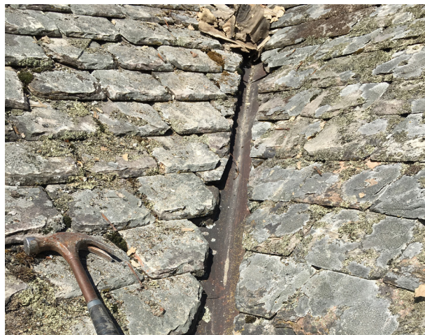
Figur 33. En äldre smal lutande rännal av plåt. Foto: Emil Engqvist.
