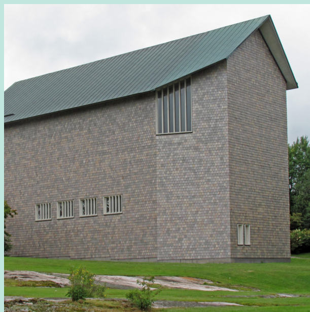
Figur 44: Storfors kyrka med skifferklädd fasad av glavaskiffer. Kyrkan uppfördes efter ritningar av arkitekt Tor Engloo och invigdes 1959. Foto: Larske, Wikimedia commons.
