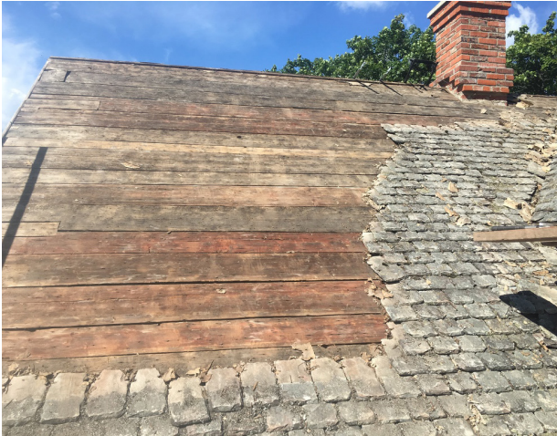
Figur 27. Underbrädorna på det här bostadshuset består av 1 ¼ tums återanvänd fasadpanel med rester av faluröd slamfärg. Foto: Emil Engqvist.
