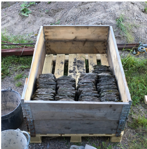
Figur 20. Kompletteringsskiffer som förvaras stående på högkant och inte direkt på marken. Foto: Emil Engqvist.
