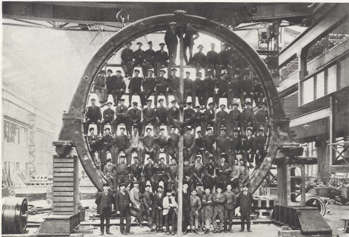
Stator till en af de tre jätte-generatorer som i dagarne levererats af allm. Svenska Elektr. Aktiebolaget i Västerås till Oxelösunds Jernverks A.-B.
