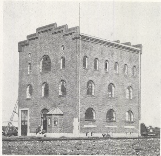
Foto. Nilson, Helsingborg.
