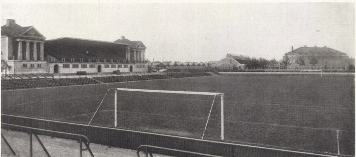
FEDERATIONSMATCHEN I KÖPENHAMN. Stadion, där den stora kraftmätningen mellan Sveriges och Danmarks bästa fotbollslag ägde rum den 4 juni.
