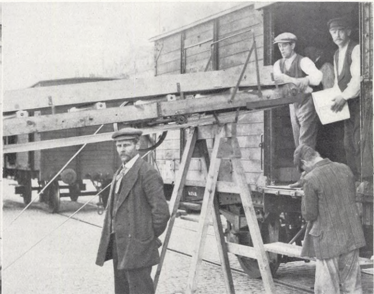
NY ANORDNING MEDELST ELEKTRISKT DRIFVEN VANDRINGSBANA FÖR TRANSPORT MELLAN JÄRVÄGSVAGNAR OCH ÅNGFARTYG AF KRIGSGÄLVOR.
