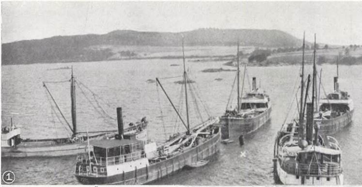
① SISTA SKEDENA I BÄRNINGEN AV "PER BRAHE". 1. LYFTFLOTTILJEN samlad kring "Per Brahe", då denne började att lyftas. Man ser ångarens skorsten vid X. 2 och 3. "PER BRAHE" UR DJUPET. 2. Akterdäck med den mycket omtalade leran synlig längst akterut. 3. Kommandobryggan och det ramponerade taket samt styrhytten.
