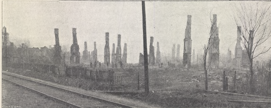
FRÅN BRANDEN I AMAL. Öfre bilden: Vy af staden från Kungsberget, tagen strax efter branden. Mellersta bilden: Eftersläckning nere vid ån. Nedre bilden: En rad af ruiner i den nedbrunna stadsdelen, strax söder om järnvägen.
