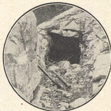
TUNNEL FÖR KANALENS AFTAPPNING. MED DENNA TUNNELS UTSPRÄNGNING BÖRJADE DET STORA ARBETET.
