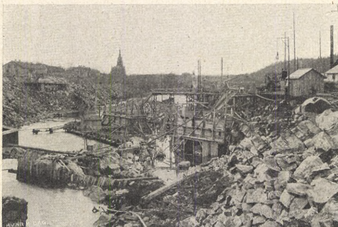
FRÅN KANALENS BÖRJAN VID INTAGET FRÅN ÄLFVEN. T. v. å foton synes Prins Oscars skola och prästgården, hvilka byggnader måste rivas, då man hunnit framdraga kanalen dit.
