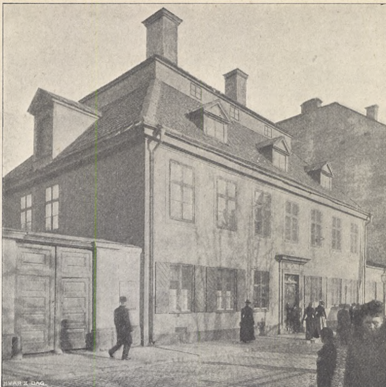
Drottninggatan 88, Härlmanska huset, fasaden.
