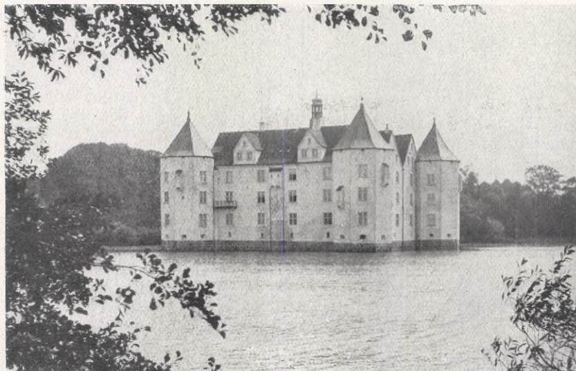
LYKSBOGERS SLOTT, hvarifrån den nuvarande danska kungafamiljen härstammar.
