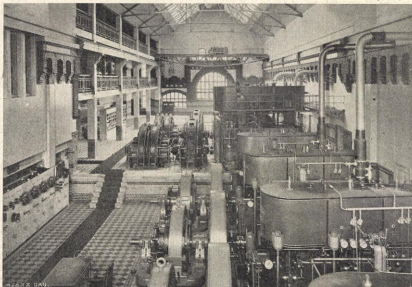
KRAFTSTATIONEN MED OMFORMAREMASKINERNA.
