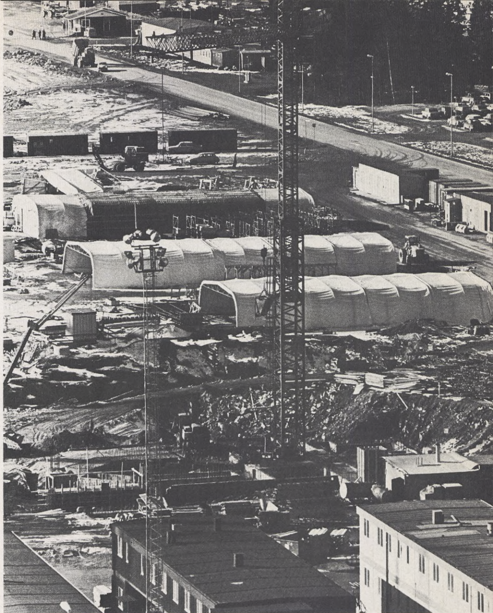
Men i Sverige bygger man för kärnkraft. Bilden visar Forsmarks kärnkraftsbygge.
