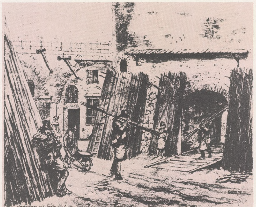
Parti av gamla järnvägen vid Söder sluss i Stockholm. Tuschlavering av A. C. Wetterling. Från 1300-talet måste allt järn som såldes i Stockholm, vägas och kontrolleras vid stadens järnvåg. – På teckningen synas järnbärare i arbete att bära jernstänger på axeln, som var försedd med en läderdyna.
