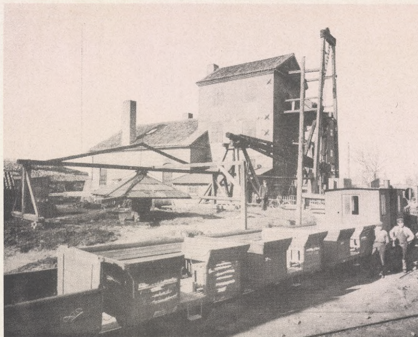
Samuel Owens ångmaskin från år 1832 vid Ryds nya schakt, Höganäs.
