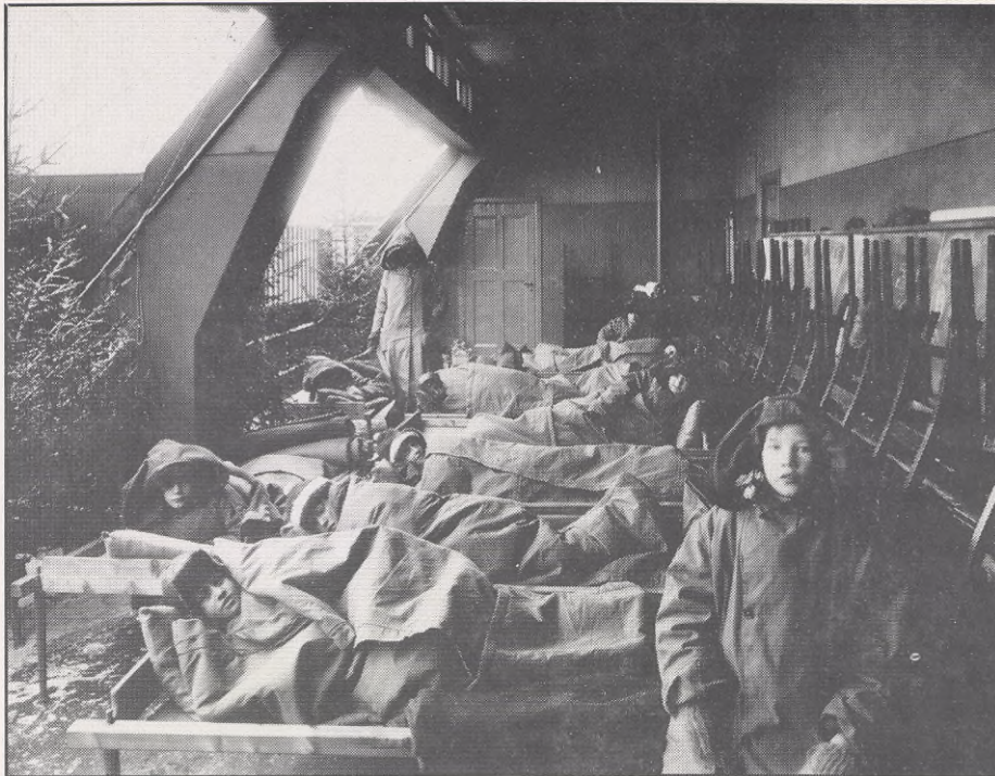
Takterrassen var öppen mot söder, men genom väggar skyddad mot andra väderstreck. Skolpulpeter fick inte plats, istället fanns lätta stolar och bord som kunde flyttas och bytas ut mot tärtsängar när barnen skulle ha liggstur. (Foto: Stockholms Stadsmuseum)
