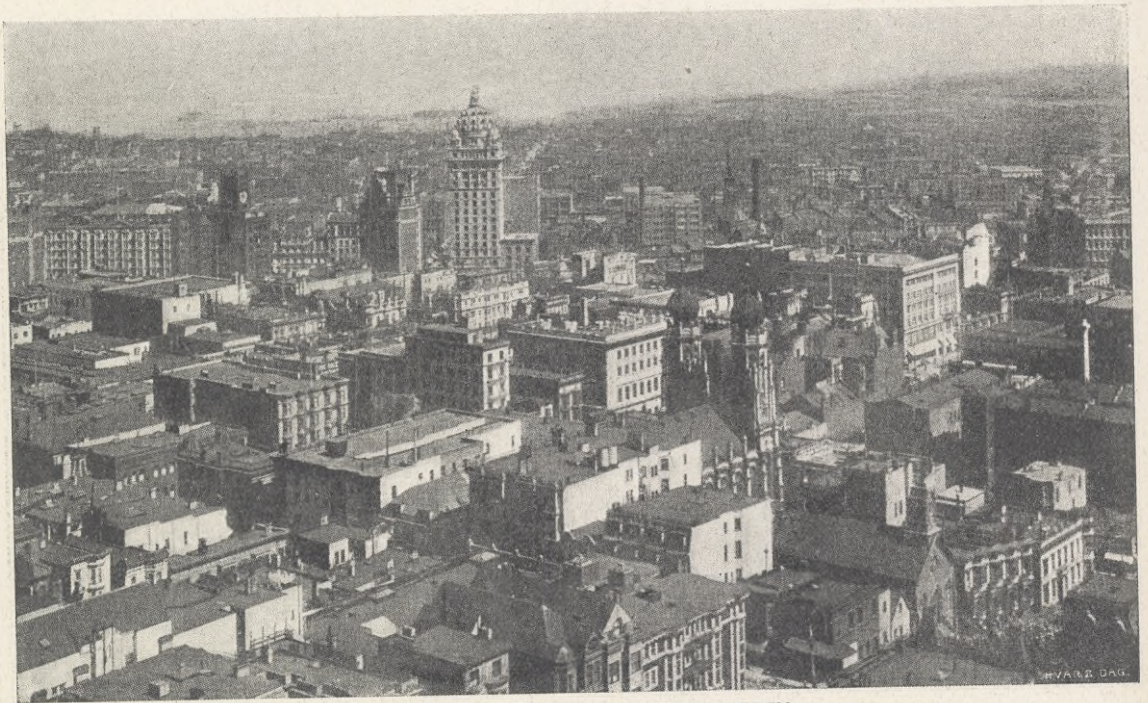
VY ÅT SÖDER ÖFVER FABRIKSKVARTEREN.
