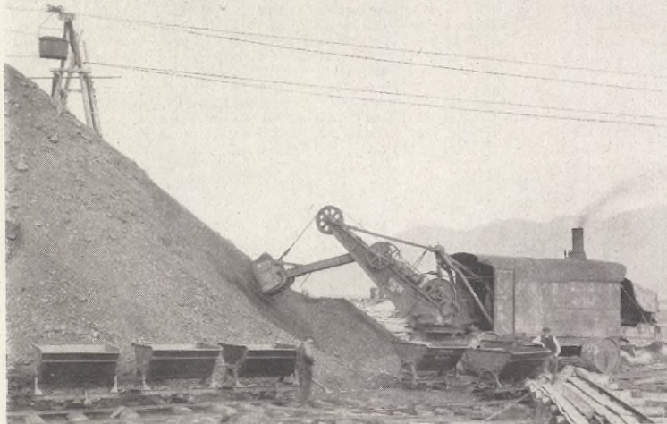
DEN SVENSKA KOLBRYTNINGEN PÅ SPETSBERGEN. Kolupplag vid Sveagravan med den stora höjbyggnaden och linbana. T. v. ANGSKOPA vid kolupplagets nedre ände.
