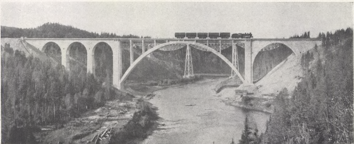
DEN NYA BETONG-JÄRNVÄGSBRON ÖVER ÖRE ÄLV, med världens största betongvalv för normalspårig järnväg. Inviges d. 5 oktober. — Efter fotografi.
