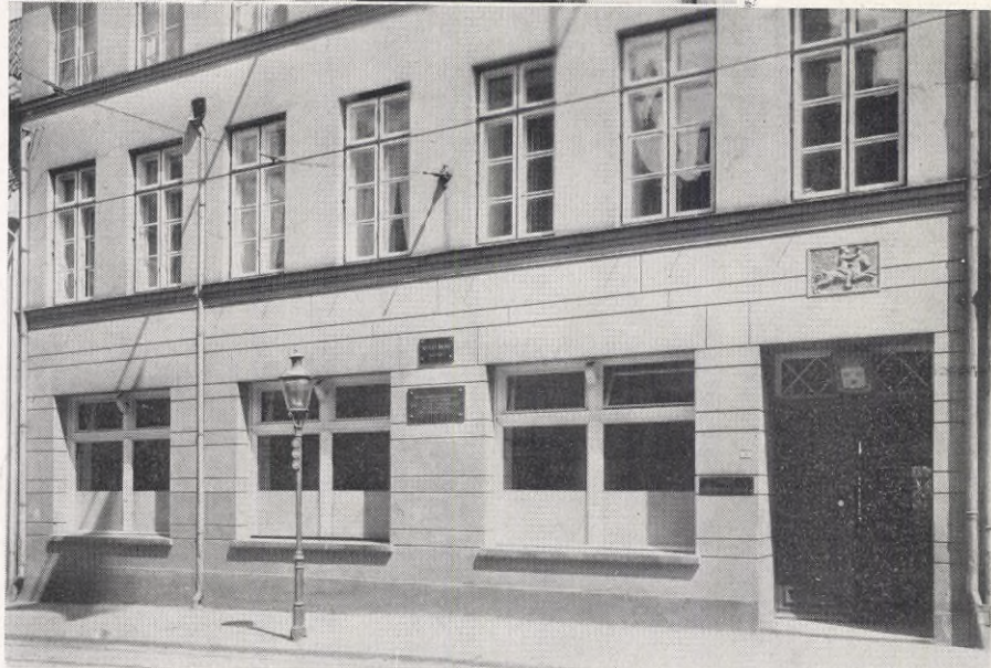
KONSUL HOLMBERGS HUS I LYBECK, Königstrasse 9, i vilket hus svenska konsulatet jämväl är inrymt. Byggnaden är förknippad med svensk historia varom två infällda tavlor vittna. Å den översta finnes inskriptionen "NICOLAUS BRÖMSE 1505—1543" å den nedersta "Medan Gustaf Eriksson Vasa biltog hade en fristad i Lübeck umgicks han flitigt i borgm. Brömsets hus. Här växte i hans sinne planen till Sveriges befrielse". — Efter fotos.
