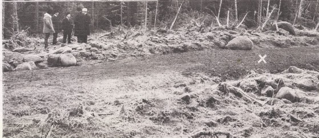
OLYCKSPLETSEN FÖR EXPLOSIONEN VID GRÄNGESBERG. En hästföra med sprängämnen på väg från Grängesberg till Svartviken den 25 november exploderade plötsligt därvid kusk, häst och vagn förintades och platsen omkring skövlades.
