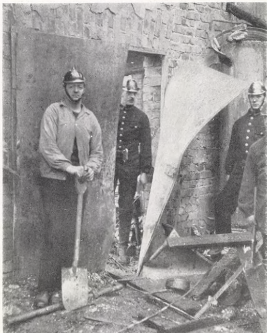
EN S. K. ELDFAST JÄRNLORR, av den starka hettan böjd som ett spån. Då dylika eldskyddande dörrar finnas litet varstades bör vara av intresse Stockholms brandkaptnens uttalande vid detta tillfälle "att om dörren i si varit av trä isolerad med asbest och plåt hade den stått sig bättre". Text å sid. 116.
