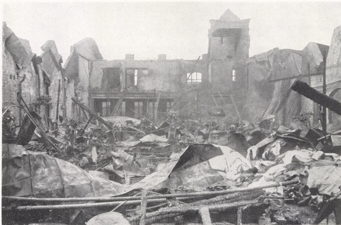
FRAN DE STORA ELDSVÅDORNA Å LILJEHOLMEN DEN 12 NOVEMBER. Den ödelagda verktygsmaskinavdelningen av Svenska Maskinverken. — to. Swinhufvud. Stockholm.
