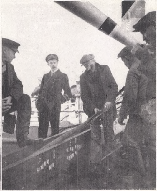
TELEFONKABEL STOCKHOLM—GOTTLAND NEDLÄGGES från den engelska kabelångaren Faraday, synlig å bilden t. v. med sina särskilda anordningar för sådana arbeten. T. h. kabeländan iordningställes då den föres i land på Gottlandskusten innan kabeln därefter föres mot fastlandet för att sammanbindas med en från Nynäshamn utgående kabel. T. v. en av de svenska experterna telegrafkommissarie W. N. Rysström. — Amatörfotos. S. Appelberg, Sthlm.
