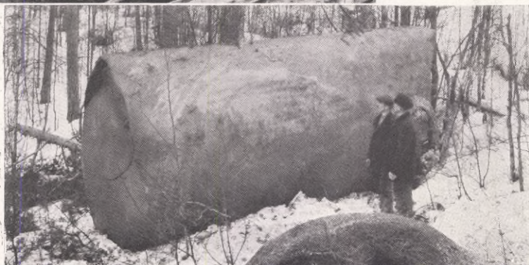
Nederst: DEN EXPLODERADE BEHÅLLAREN, efter en 100 meters färd genom luften, hamnad i skogen.
