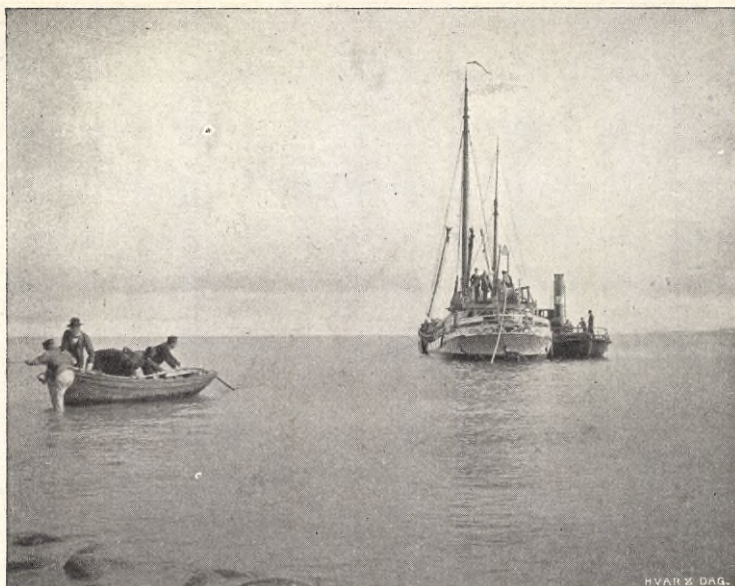
KABELN ILANDFÖRES Å ÖSTGÖTASIDAN.
