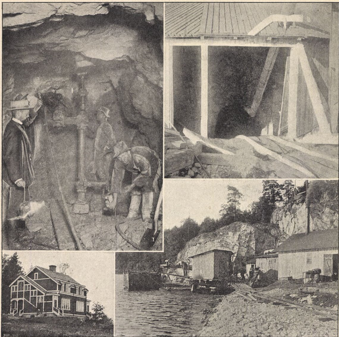
STOCKHOLMS NYA VATTENVERK: 1. Tunneln borrar med elektriska bormaskiner; t. v. står chefen för tunnelarbetet, ing. Meurling. 2. Den underjordiska vattentunneln vid Bomsjön. 3. Bostad för gifta arbetare vid Norsborg. 4. Tunnelns utlopp i Bomsjön; t. h. det efter explosionen återbyggda maskinhuset.
