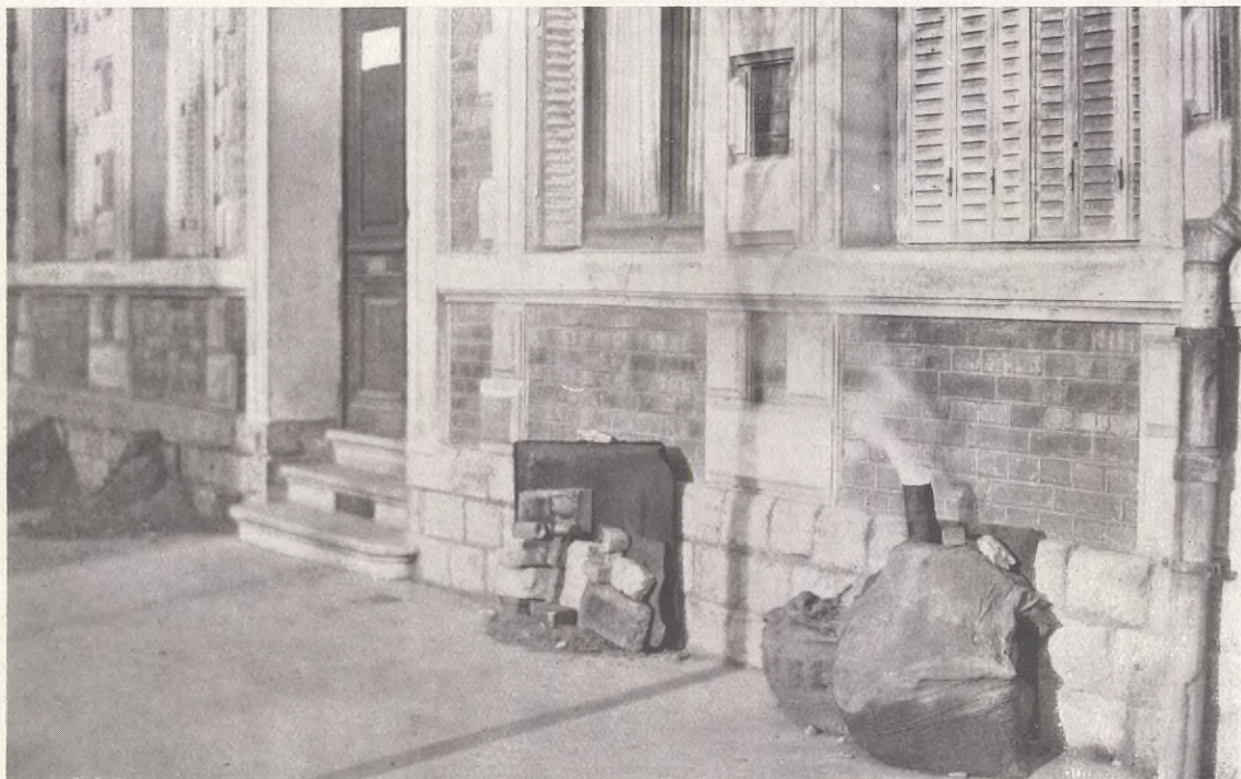
KÄLLARBOSTÄDER I STRIDSOMRÅDET VID VÄSTFRONTEN, i hvilka man inrättat sig till skydd för artilleri- och aeroplanbombardement. Observera stenhögarne framför fönstren och kaminrören till de provisoriska eldstäderna.
