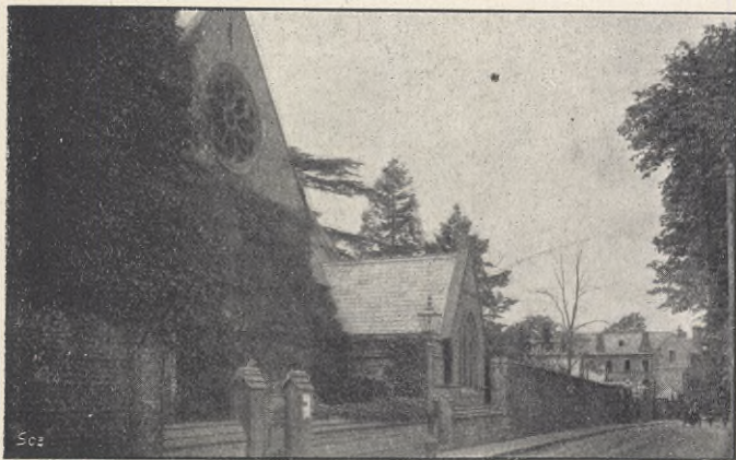
ROEHAMPTON: Den gamla kyrkan bredvid konungaparets blifvande residens.
