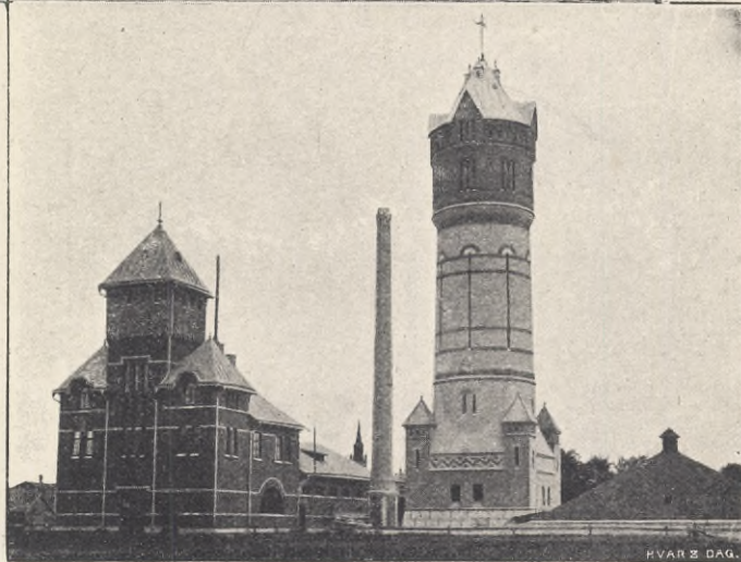
VATTENTORNET jämte maskinhus, vattenreservoar m. m.
