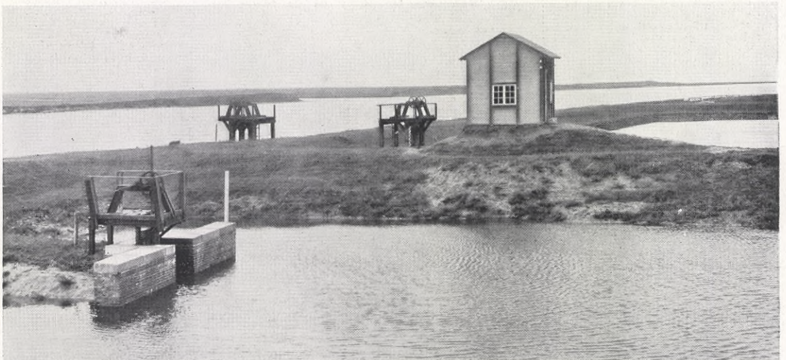
HAFVETS EBB- OCH FLODRÖRELSE SÅSOM KRAFTKÄLLA. En elektrisk försöksstation vid Husum. Vy öfver anläggningen; man ser den högre (närmaste) och den lägre vattenbassängen jämte turbinhus och slussanläggningar.
