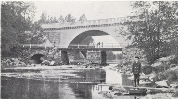
SVERIGES FÖRSTA JÄRNVÄGSBRO AF BETON, ÖFVER FRÖVIÅN, byggd under sommaren och nyligen tagen i trafikbruk. småttärfotografi
