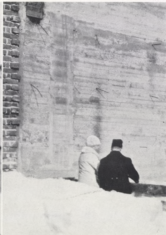
KRONPRINSEN VID STÄLLVERKET, ledsagad af generaldirektör Granholm.
