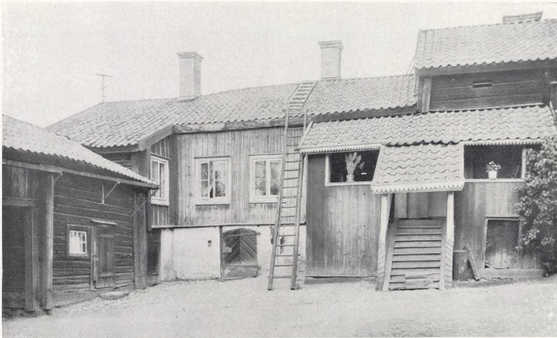
GRASSAGÅRDEN I STRÄNGNÄS, ett enastående medeltidsminne, som snart kommer att förisvinna och lämna plats för ett "modernt hus", därest ej stad eller stat träder emellan.
