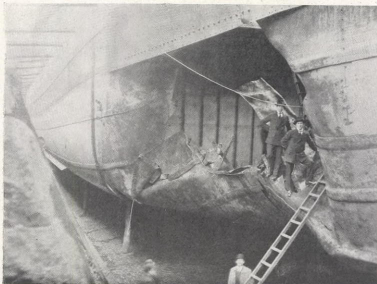
DEN MINSPRÄNGDE ÅNGAREN "PRINSESSAN INGEBORG" I LINDHOLMENS DOCKA. En god bild af skadan. — Amatörfoto. P. Samuelsson, Gbg.
