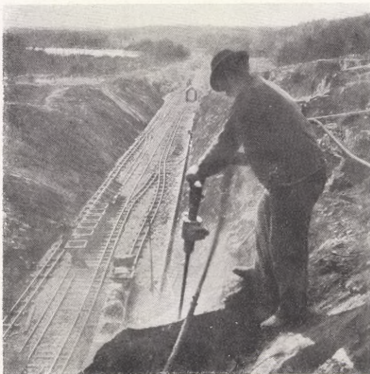
efter fotografi BERGBORRMASKIN I ARBETE. I fonden Floda station. Kliche: Benot Silfversparre.
